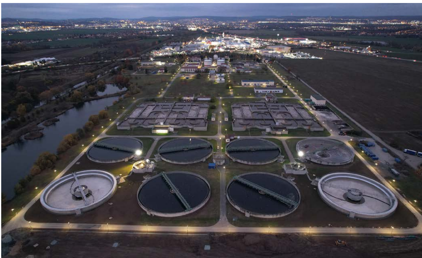
Čistírna odpadních vod Brno – Modřice, pohled na dosazovací nádrže
